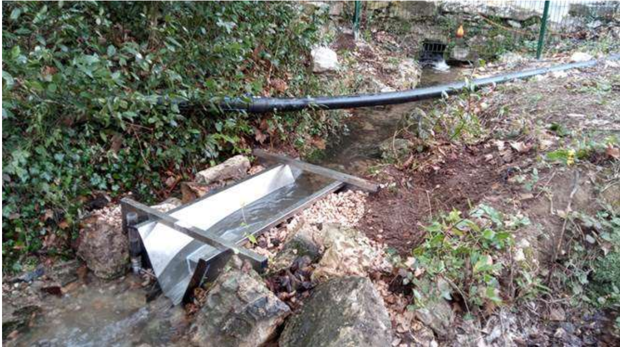
Figure 26. Canal de mesure installé par la CAPV sur l'exutoire de la source pour les essais de pompage de longue durée
